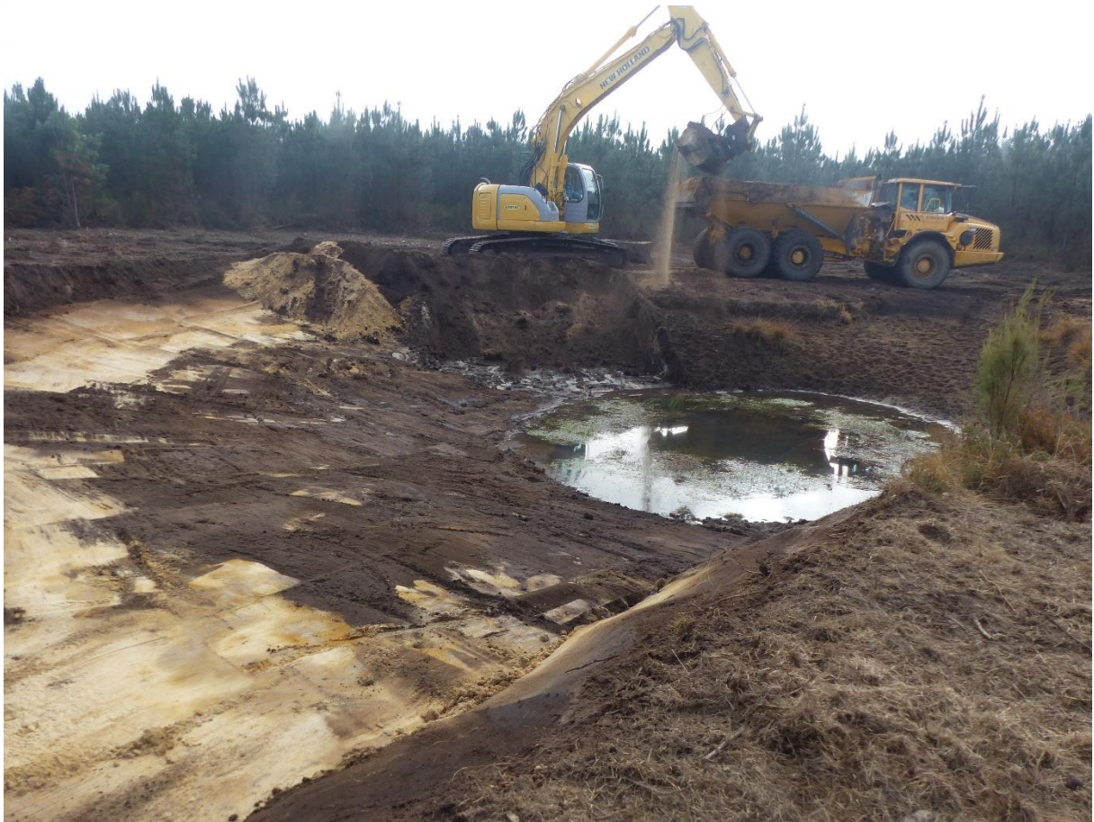
Reprofilage des berges de la lagune en cours – 20 novembre 2017
