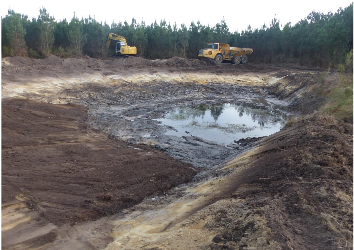
Reprofilage des berges de la lagune en cours : du substrat organique a été étalé sur une partie de la zone décapée pour faciliter la reprise de la végétation (en bas à gauche) – 20 novembre 2017
