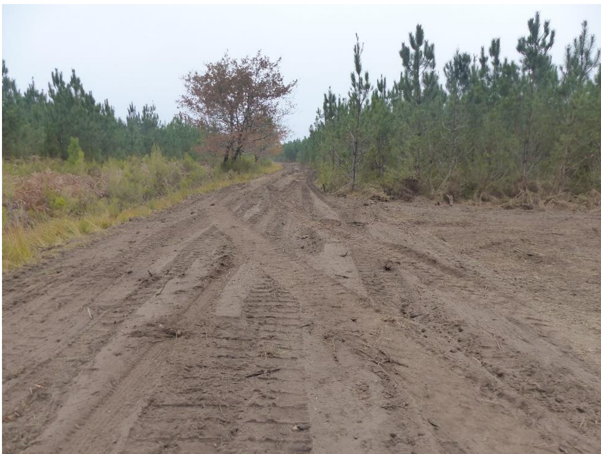
Les déblais ont été étalés sur une bande de roulement à proximité de la lagune – 21 novembre 2017
