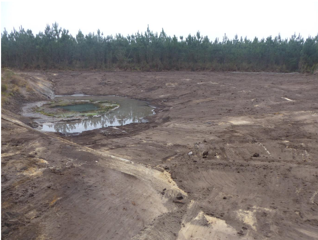
Vue d'ensemble des travaux de restauration achevés – 21 novembre 2017
