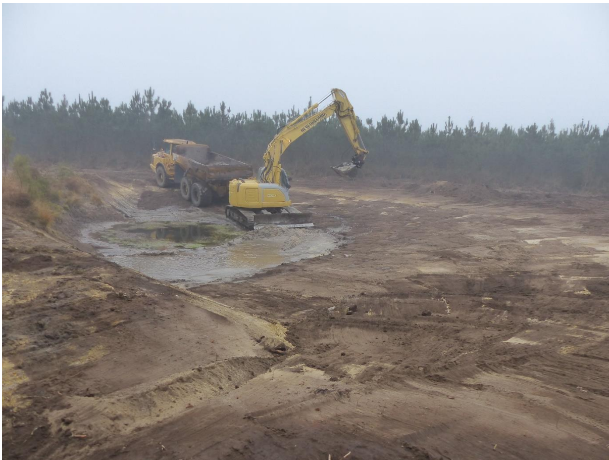
Le reprofilage des berges de la lagune est terminé. La différence d'inclinaison de pente entre la berge non-reprofilée (à gauche) et la berge reprofilée (à droite) est bien visible sur cette photo. L'agrandissement de la lagune est en cours (bande de 2 mètres sur environ une quarantaine de centimètres de profondeur autour de la lagune) – 21 novembre 2017
