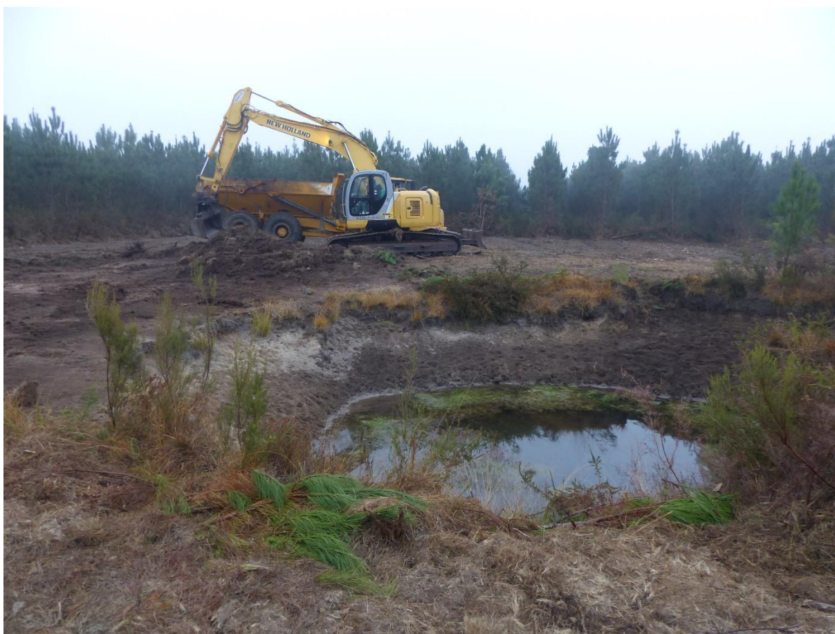
Début des travaux de reprofilage des berges de la lagune – 20 novembre 2017
